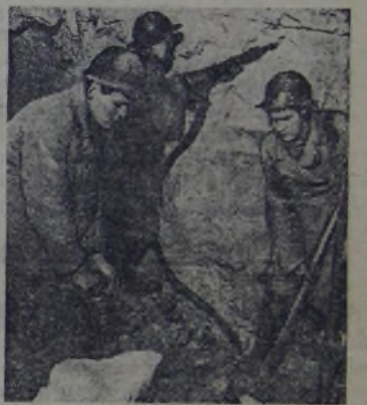
В Москве строят четвертую очередь метрополитена. На этом снимке вы видите, как под землей работают проходчики.
