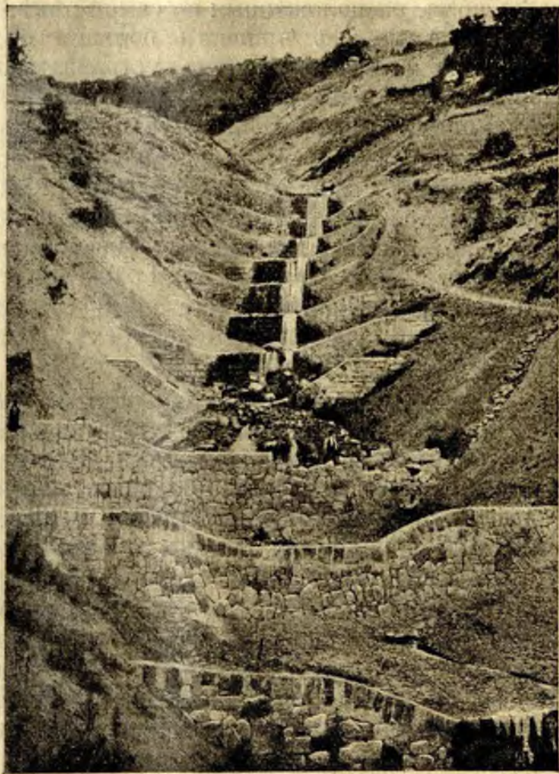
Способъ регулированія теченія горнаго потока въ Швейцаріи.
