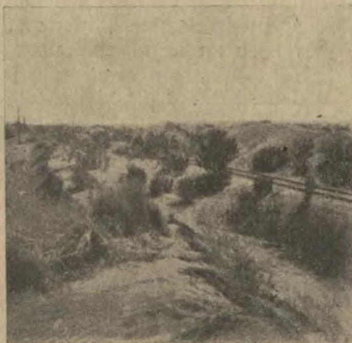
Фиг. 24. Искусственные насаждения по линии Средне-Азиатской жел. дор., близ ст. Караул-Кую, среди сыпучих песков. На ближайших к полотну барханах виден заборчик из сухих веток, на самом полотне развивается искусственно посаженная растительность. Пустыня Кара-кум. (Фот. Б. Е. Жадовского).
