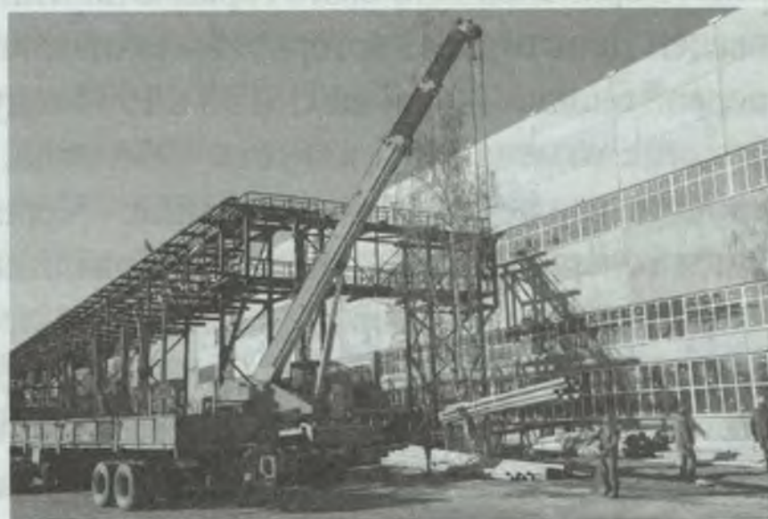
Строительство нового цеха электролиза меди. Май 2011 года.
